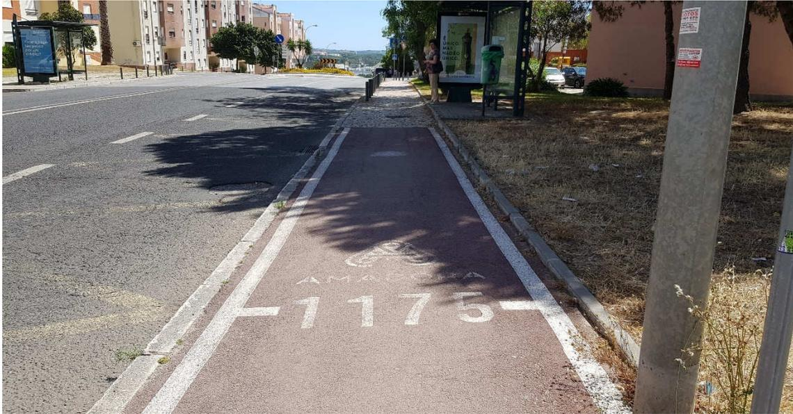
Figura 21 - Pista dedicada, piso diferenciado no material e na cor. Estrada do Zambujal, sentido norte-sul. Julho de 2018
