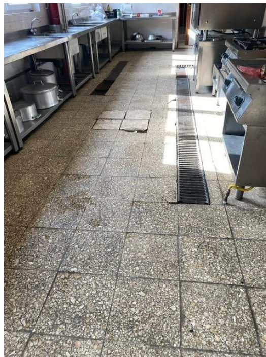
Pavimento da cozinha
