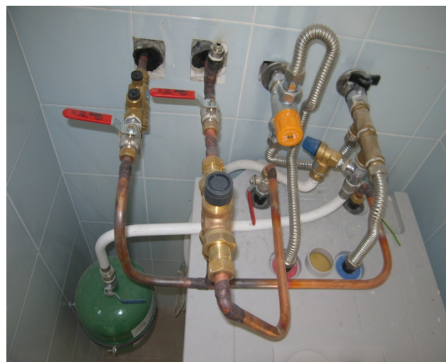
Depósito de acumulação de AQS
