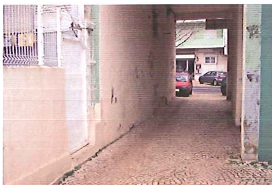
Foto 13 – Galeria de Acesso
