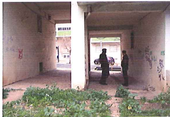
Foto 12 – Galeria de Acesso
