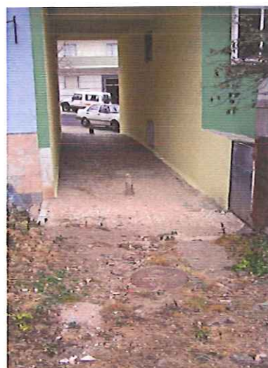
Foto 8 – Galeria de Acesso Existente
