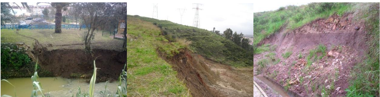
Fig. 10 - Movimento de terrenos ocorridos no mês de janeiro de 2010 (Esquerda: Parque do Lido; Centro: A9/CREL; Direita: Rotunda da Cruz Vermelha) 27
