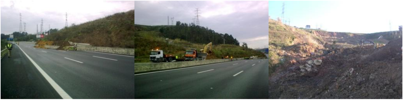
Fig. 9 - Movimento de terrenos na A9/CREL (km 9,6 sentido Estádio Nacional – Alverca) 25
