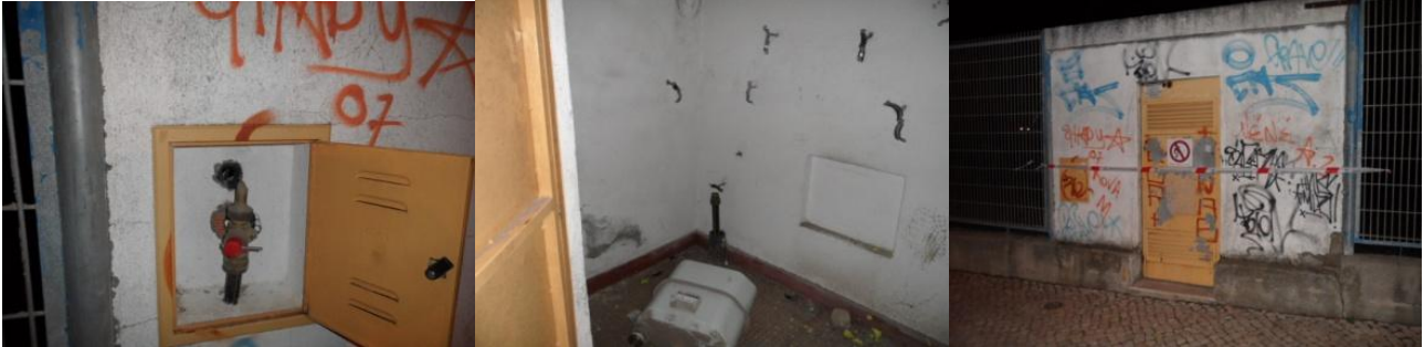
Fig. 16 - Fuga de gás na Escola Básica 2+3 de Alfovelos (Amadora) 38
