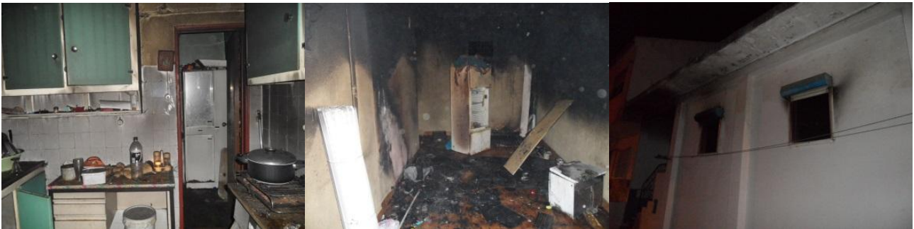
Fig. 15 - Incêndio urbano na Rua Latino Coelho na Venda Nova (Amadora) 34
