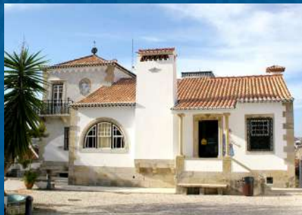
Fachada sur de la Casa Roque Gameiro, 2016 © Luísa Baeta
