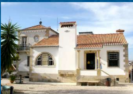
Façade sud de la maison 2016 © Luísa Baeta
