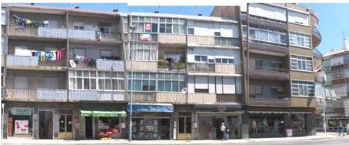
Figura 2.22 - Fotografia dos edifícios nº 176 a 170 (foto Helena Almeida, 2013)
