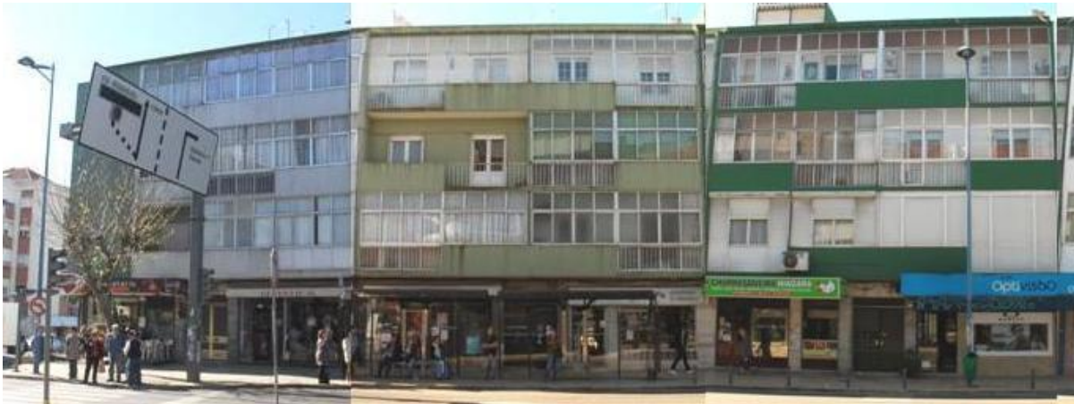
Figura 2.26 - Fotografia dos edifícios nº101 a 105 (foto Helena Almeida, 2013)
