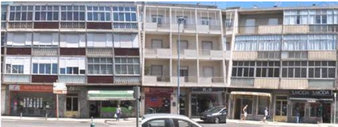
Figura 2.19 - Fotografia dos edifícios nº 182 a 178 (foto Helena Almeida, 2013)
