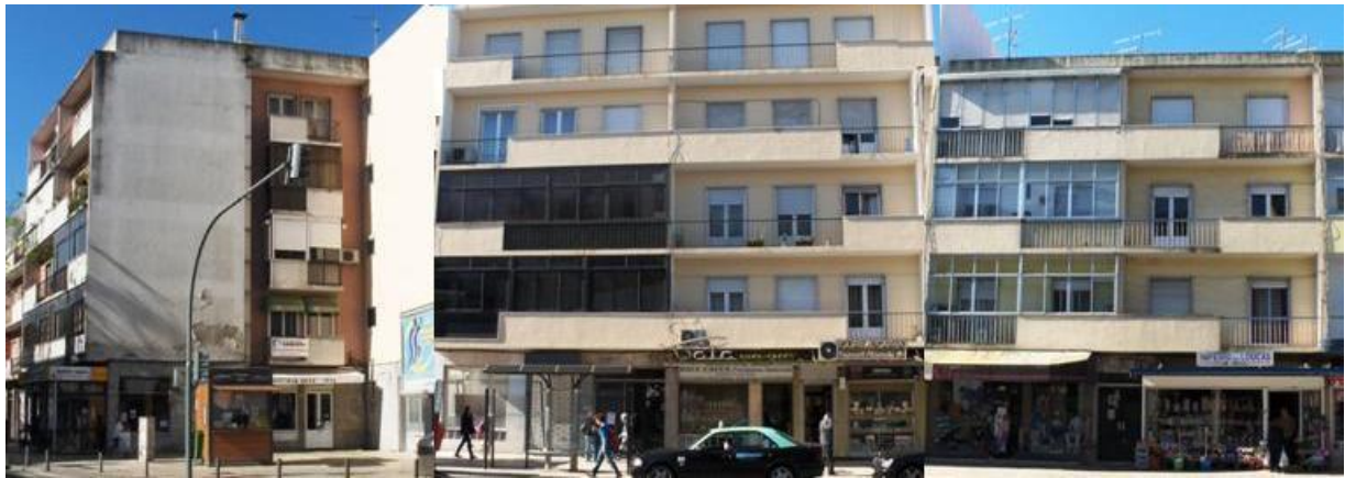
Figura 2.32 - Fotografia dos edifícios nº113 a 117 (foto Helena Almeida, 2013)
