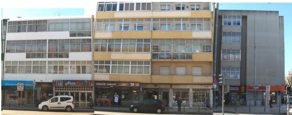
Figura 2.29 - Fotografia dos edifícios nº107 a 1 (foto Helena Almeida, 2013)
