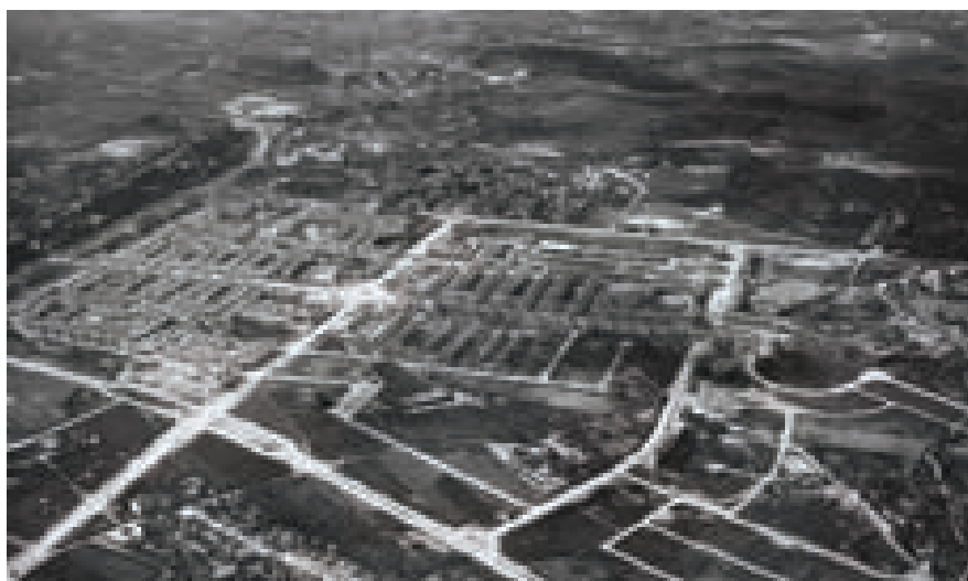
Ilustração 107 - Fotografia aérea sobre o bairro de Alvalade, 1950. Construção das primeiras células, I, II e infraestruturação. (Lisboa. Câmara Municipal. Arquivo Municipal, 1950).
