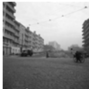
Ilustração 110 - Construção da avenida dos Estados Unidos da América, década de cinquenta. (Lisboa. Câmara Municipal de Lisboa, 1950).
