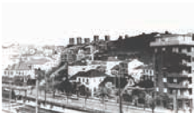
Ilustração 42 - Bairro da Mina, moradias e os primeiros edifícios desenvolvidos em altura, junto ao caminho de ferro. s.d. ([Adaptado a partir de:] Amadora. Câmara Municipal. Núcleo Museográfico do Casal da Falagueira, s.d.).
