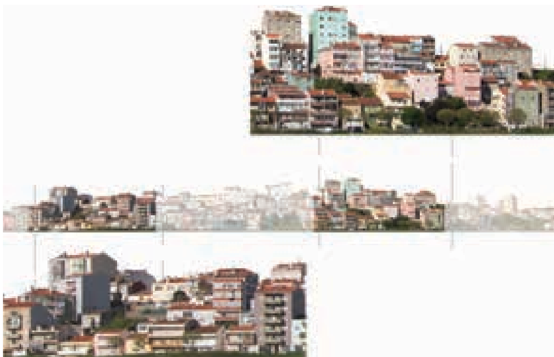
Ilustração 48 - Panorâmica da paisagem urbana da Brandoa, passagem pela CRIL em 2017. (Ilustração nossa, 2017).
