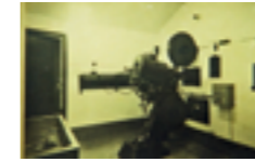
- 5 - A sala de projeção dos Recreios, após as obras de 1943. C.M.A. - Arquivo do MMAR
