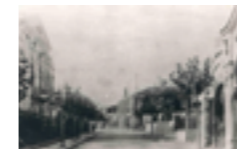
- 4 - Outra imagem do exterior do Salão de Festas, vendo-se, em frente, parte do edifício do cinema da Amadora. C.M.A. - Arquivo do MMAR.
